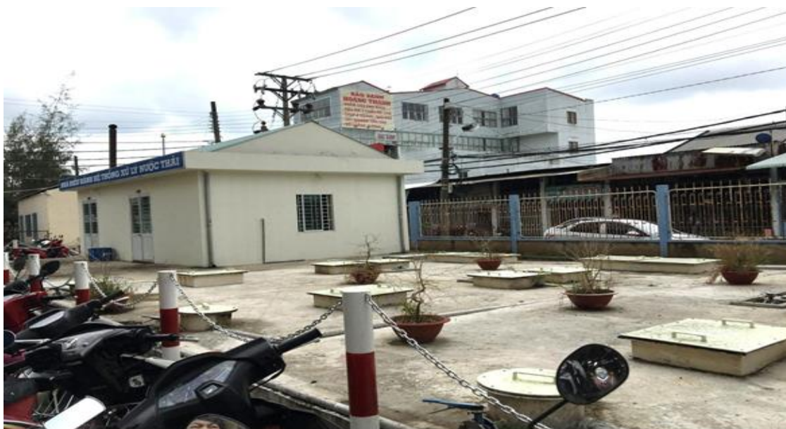
Hình 2.4. Hệ thống xử lý nước thải Bệnh viện Chuyên khoa Sóc Trăng
